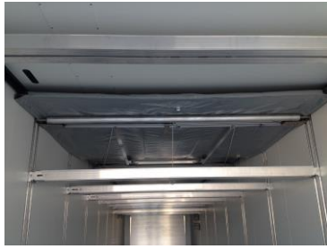
Grundstellung der Trennwand
