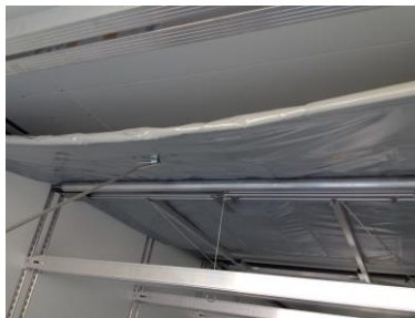
Trennwand mit der Stange nach hinten heraus ziehen, bis die TW mit der Hand greifbar ist.
