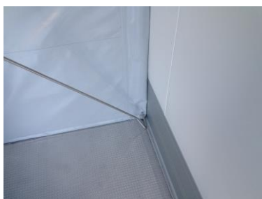
Falze der Trennwand an den Ecken an die Wand drücken, damit eine absolute Dichtigkeit gewährleistet ist.
